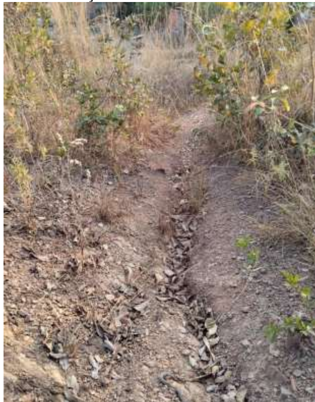
Figura 6 – Presença de Sulco Profundo na Área de Estudo.
