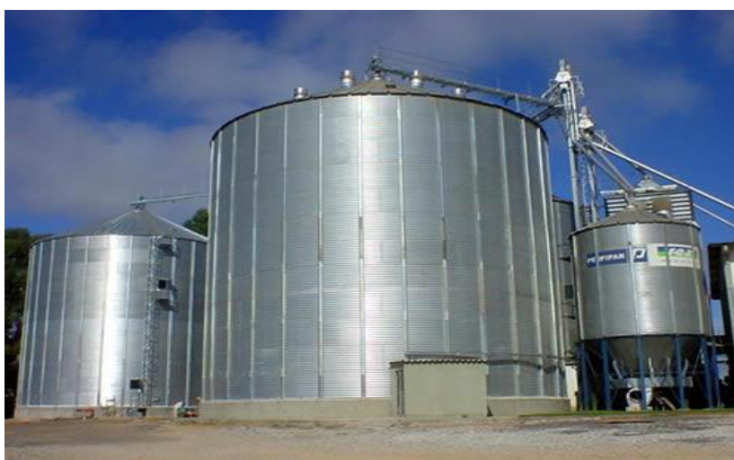
Figura 9. Silo vertical metálico.
