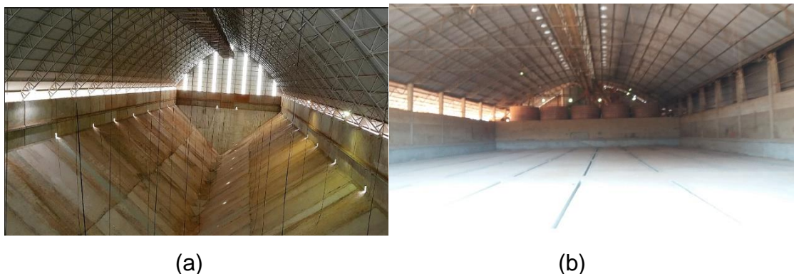
Figura 8. Armazém graneleiro de fundo em V (a), e fundo plano (b).
