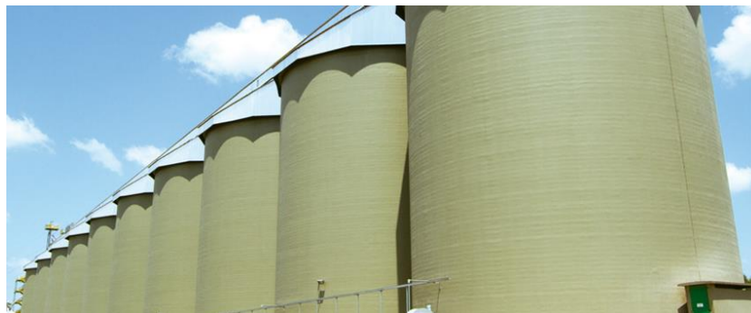
Figura 11. Conjunto de silos de concreto.
