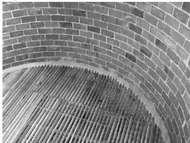
Figura 14 – Interior de um silo secador com fundo falso.
