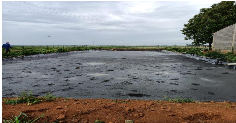
Figura 5 - Lagoa anaeróbia utilizada para tratamento da ARS. Fonte: Autora.
