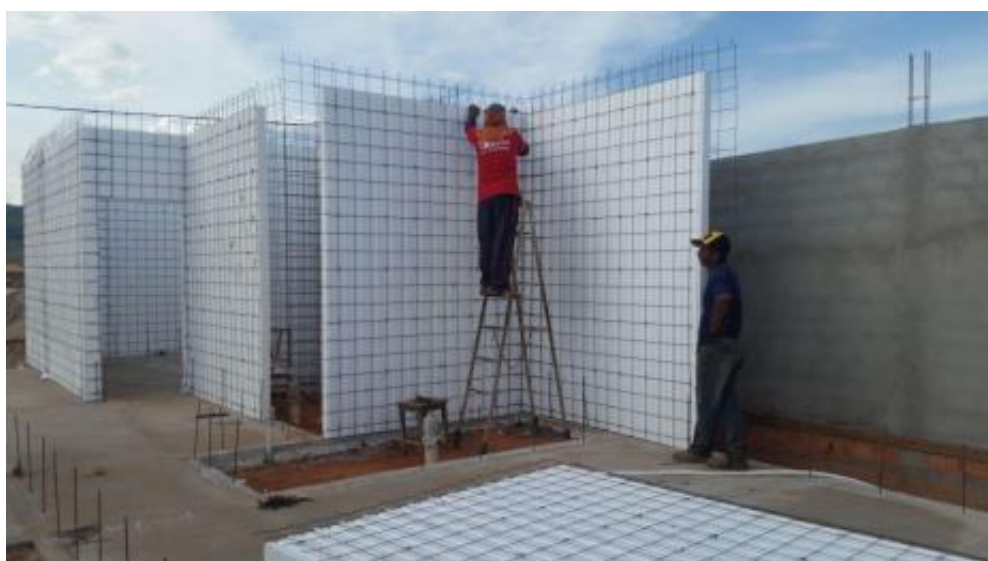
Figura 8 - Encaixe dos painéis sobre a fundação.
