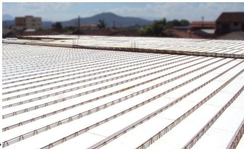
Figura 7 - Laje pré-moldada treliçada com EPS.
