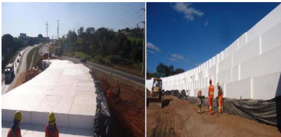
Figura 13 - Imagem da aplicação do EPS na rodovia (SP-360).
