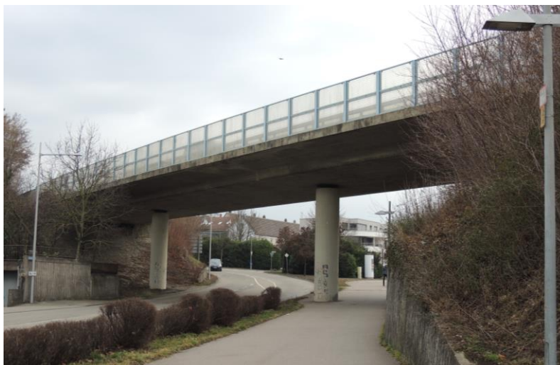
Figura 2. Ponte em concreto protendido. Instalação de um sistema de monitoramento em fibra ótica em parceria com o Regierungspräsidium (RP)
