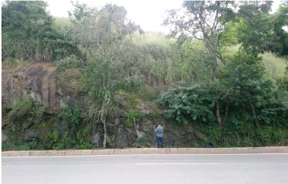
Figura 19 - Presença de vegetação na face do talude
