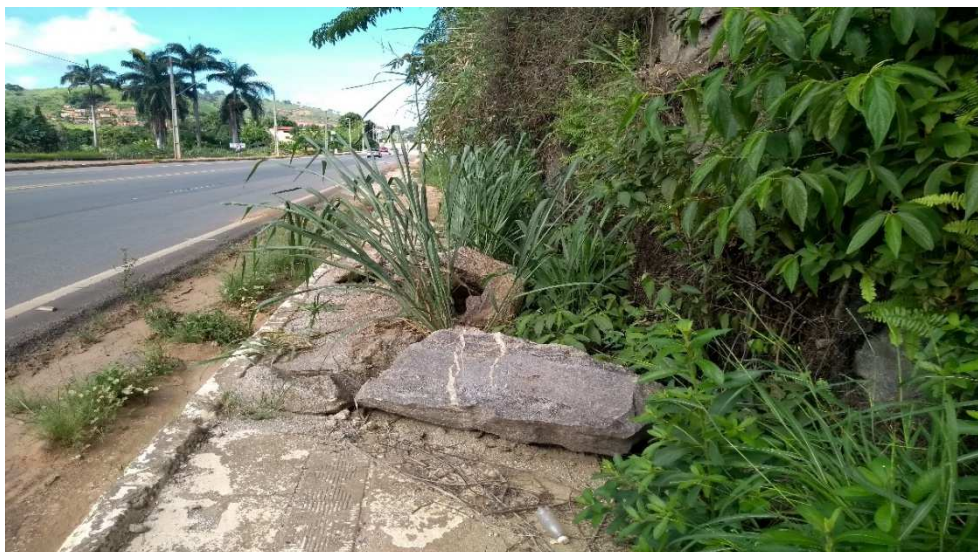
Figura 21 - Obstrução do passeio
