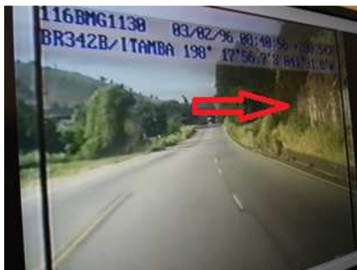
Figura 11 - Registro do maciço em 1996
