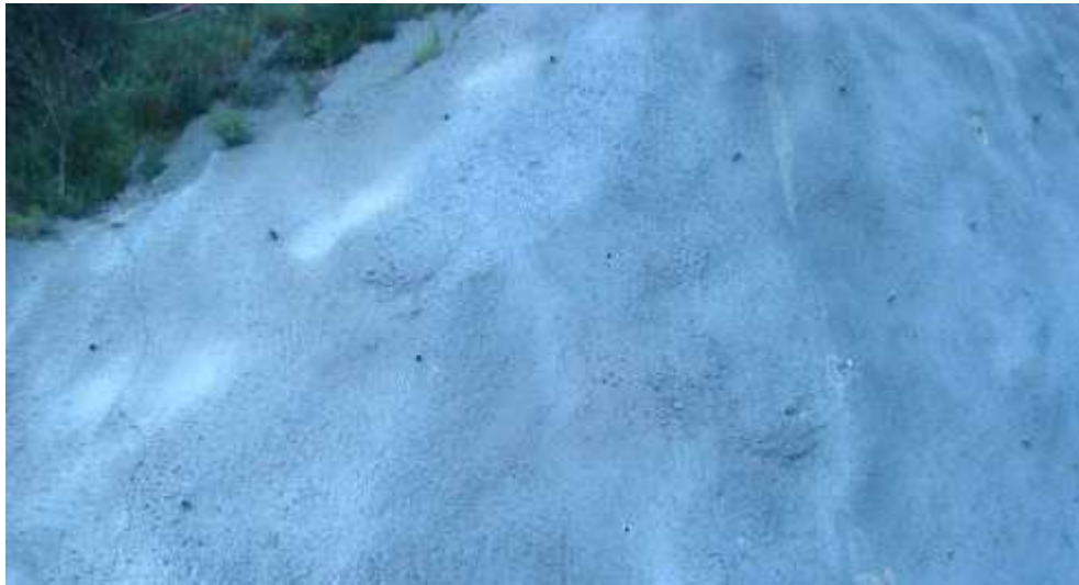
Figura 8 - Talude com concreto projetado e furos de drenagem
