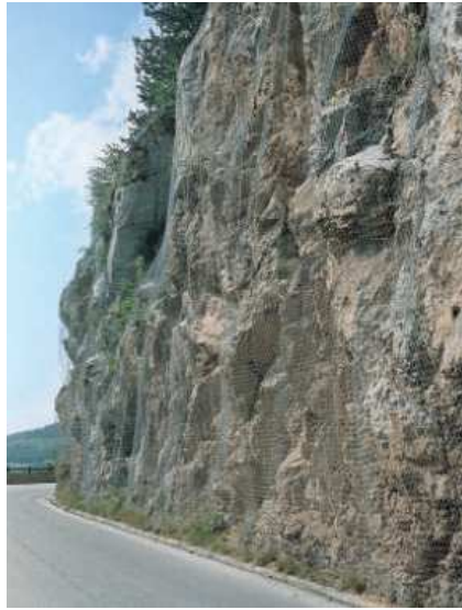
Figura 4 - Sistema de Revestimento Simples
