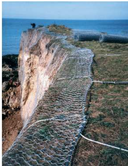
Figura 5 - Sistema de Revestimento Simples, ancorado no topo
