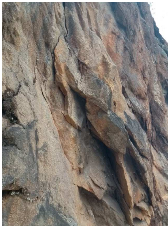
Figura 25 - Bloco de rocha na iminência de ruptura
