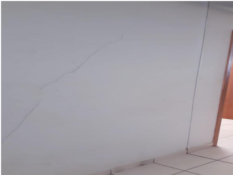
Figura 27: Vista de fissura na alvenaria do corredor I do bloco de salas de aula
