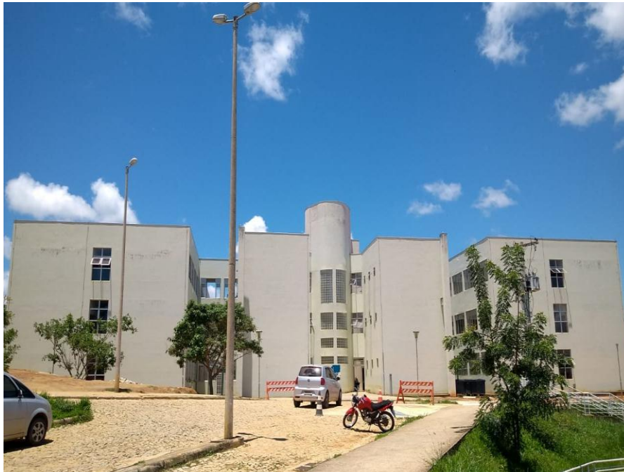
Figura 21: Vista frontal do bloco de salas de aula
