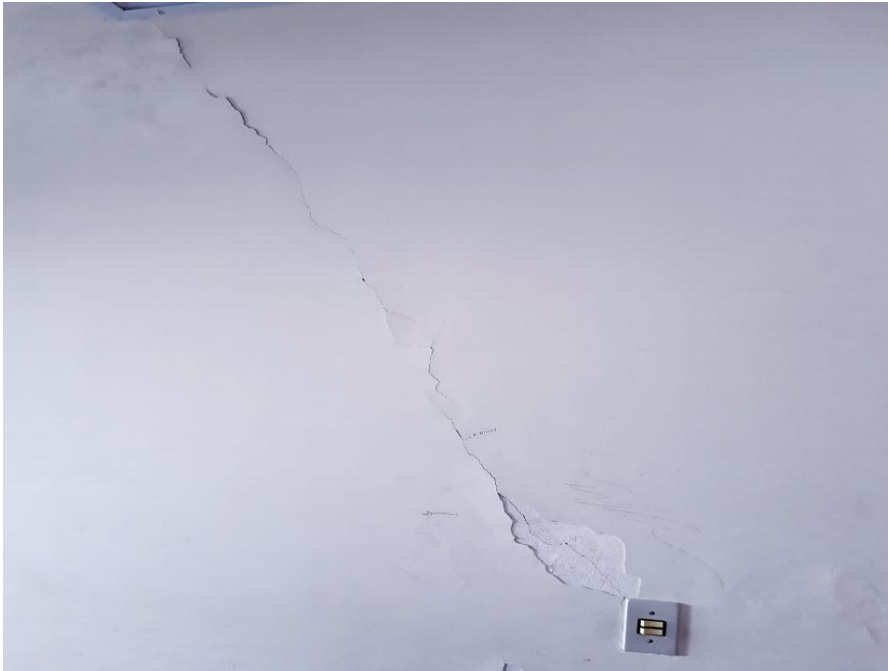
Figura 24: Vista de fissura na alvenaria da sala 109 no bloco de salas de aula
