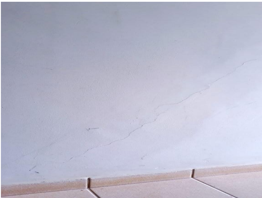
Figura 33: Vista de fissura no corredor do Prédio da Medicina
