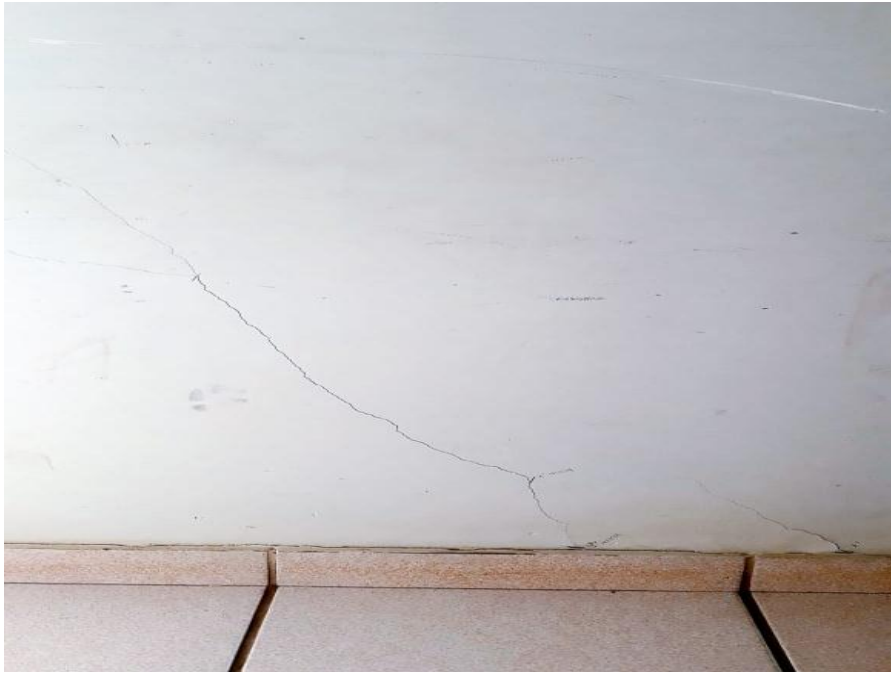
Figura 30: Vista de fissura no corredor II do bloco de salas de aula
