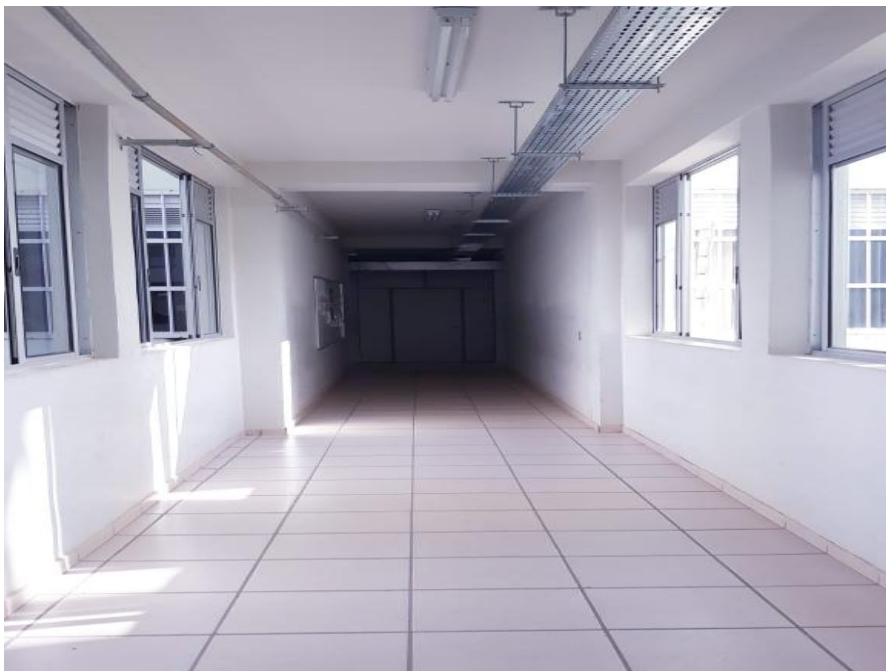
Figura 29: Vista do corredor II do bloco de salas de aula
