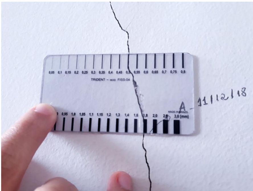
Figura 25: Vista da espessura da fissura (0,5 mm) da sala 109 no bloco de salas de aula
