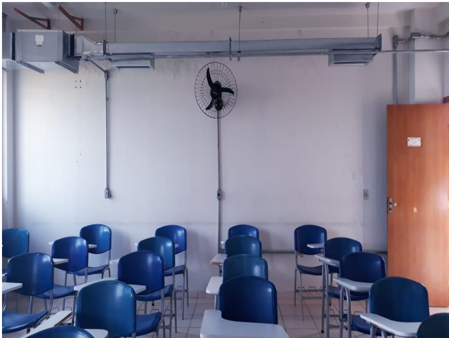
Figura 23: Vista da sala 109 no bloco de salas de aula
