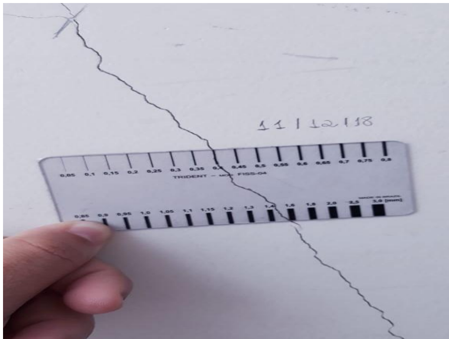
Figura 31: Vista da espessura da fissura (0,400 mm) no corredor II do bloco de salas de aula
