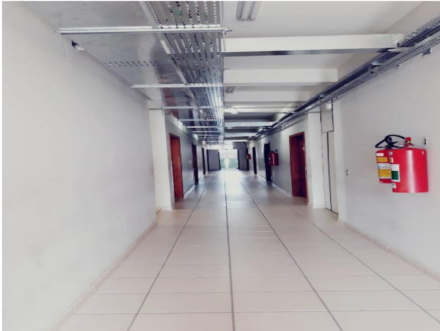
Figura 26: Vista do corredor I no bloco de salas de aula
