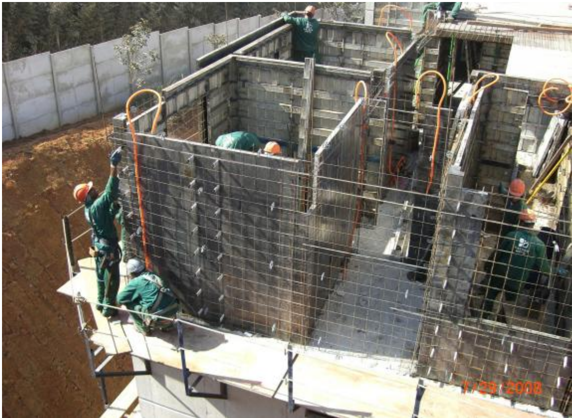
Figura 3 – Montagem dos painéis internos
