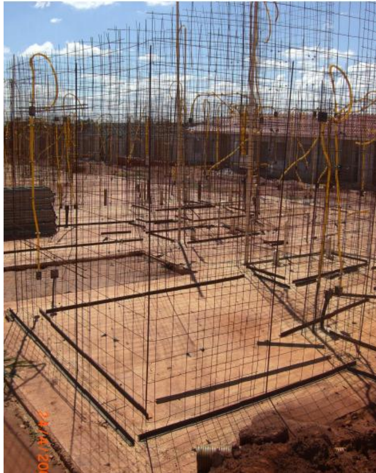
Figura 2 – Montagem das instalações prediais
