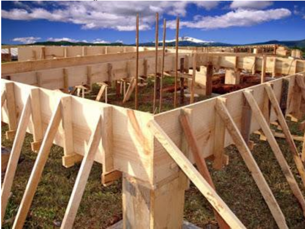
Figura 1 - Escoras e fôrmas de Madeira
