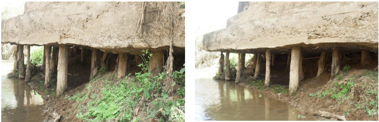
Figura 3 - Estacas desconfinadas suscetíveis ao ataque biológico
