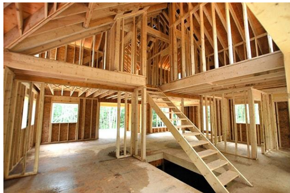
Figura 6 – Parte Interna em Wood Frame
