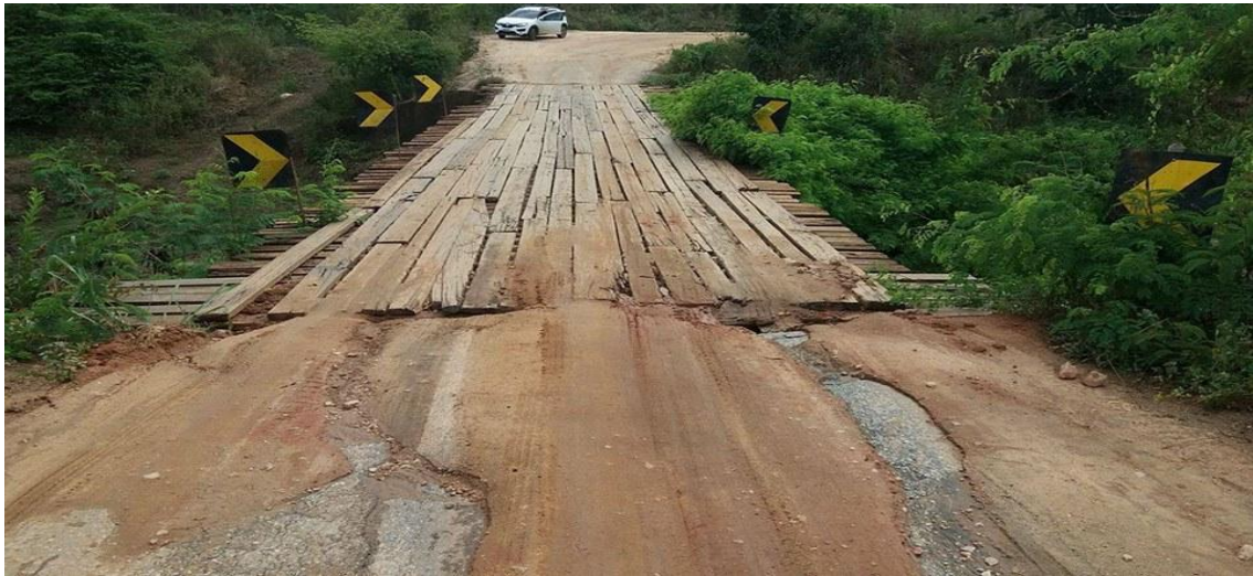
Figura 2 - Ponte na BR 367 entre as cidades de Jacinto e Salto da Divisa (MG)
