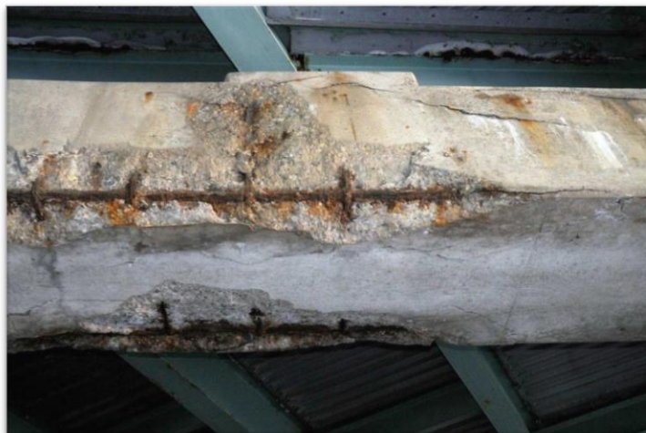
Figura 8 - Carbonatação do concreto e corrosão das armaduras
