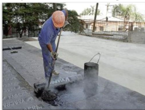
Figura 15 - Manta asfáltica a quente
