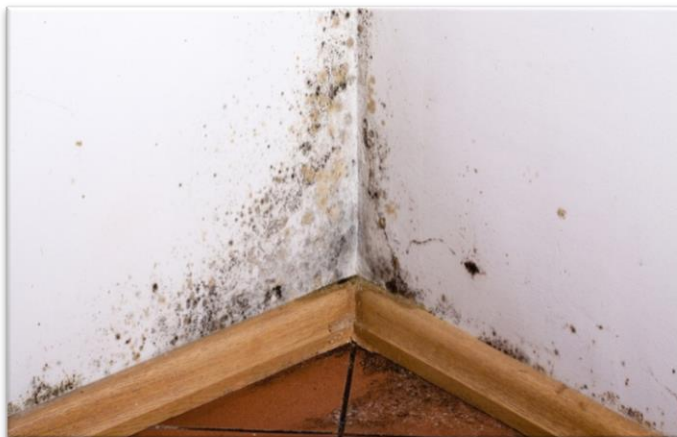
Figura 10 - Aglomeração de fungos em paredes
