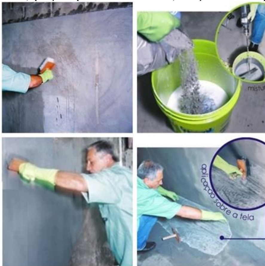
Figura 27- Sequência de aplicação da argamassa polimérica: limpeza e umedecimento; mistura dos componentes; aplicação em parede com o uso de trincha; utilização de armadura tipo tela.
