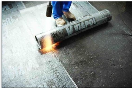
Figura 16 - Manta asfáltica aplicada com maçarico
