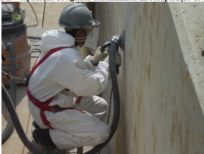
Figura 29 - Aplicação de agentes cristalizantes na recuperação de parede
