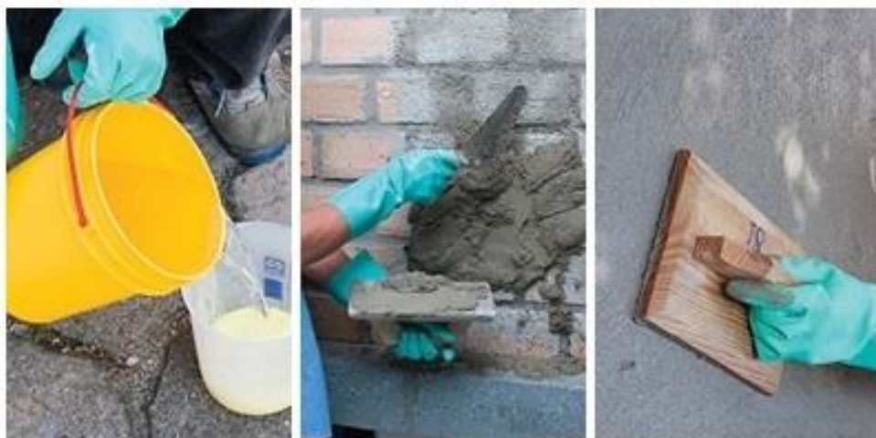
Figura 25 - Aplicação da Argamassa com Aditivo Hidrófugo
