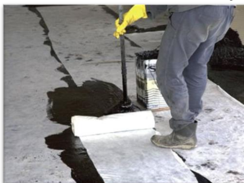
Figura 14 - Membrana asfáltica in loco a frio com o reforço do véu de poliéster
