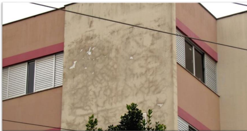
Figura 12 - Alteração na pintura de um edifício devido à umidade
