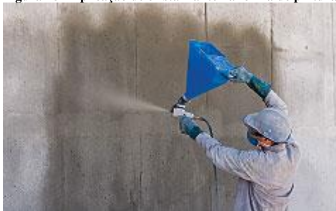
Figura 28 - Aplicação de cristalizante na forma de pintura.
