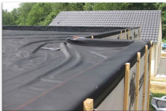
Figura 23 - Manta em EPDM para impermeabilização de telhado
