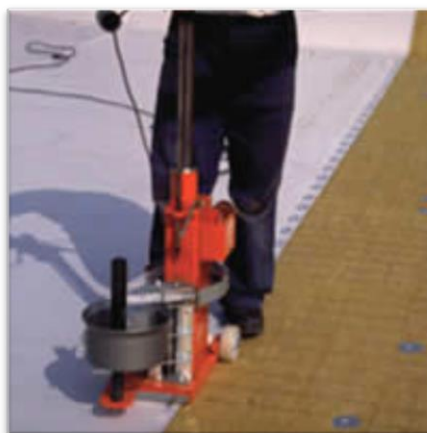
Figura 17- Fixação automática da membrana de PVC com parafusos e arruelas especiais
