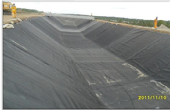
Figura 21 - Canal de adução utilizando geomembrana PEAD
