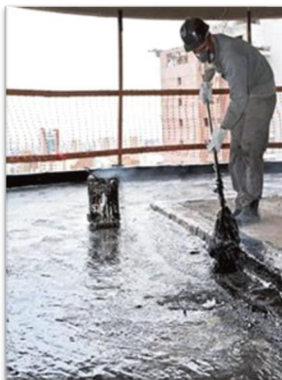
Figura 13- Membrana asfáltica sendo moldada in loco a quente
