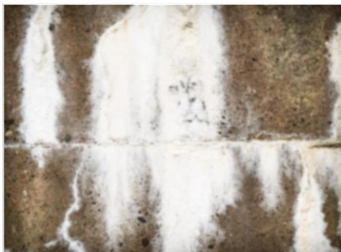
Figura 7- Eflorescências em alvenaria
