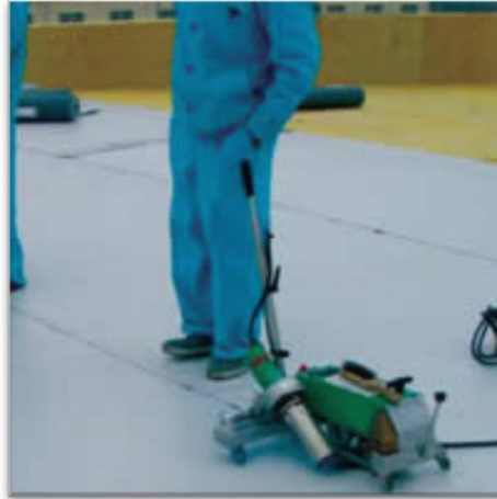
Figura 18 - Processo de solda com equipamento apropriado
