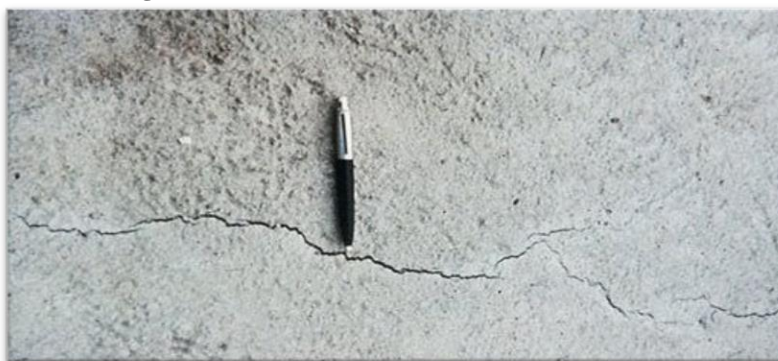
Figura 9 - Trinca em alvenaria devido à umidade
