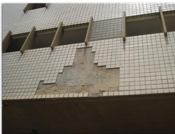
Figura 11 - Destacamento cerâmico em fachada de edifício
