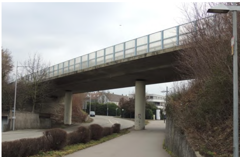
Figura 2. Ponte em concreto protendido em Neckarsulm. Instalação de um sistema de monitoramento em fibra ótica em parceria com o Regierungspräsidium (RP)
