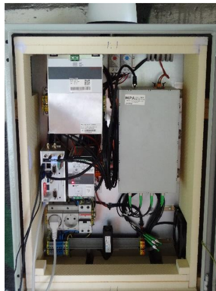
j. Interior da cabine de controle (equipamento de aquisição de dados, computador industrial, sistema de proteção contra queda de energia, model LTE).
