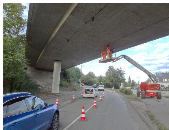
h. Fechamento parcial da rua durante a instalação
