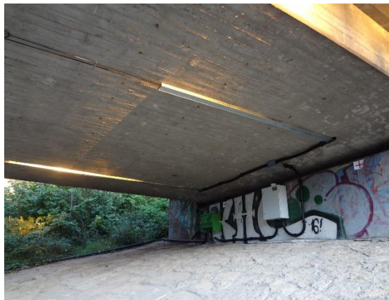
i. Vista da cabine de controle
