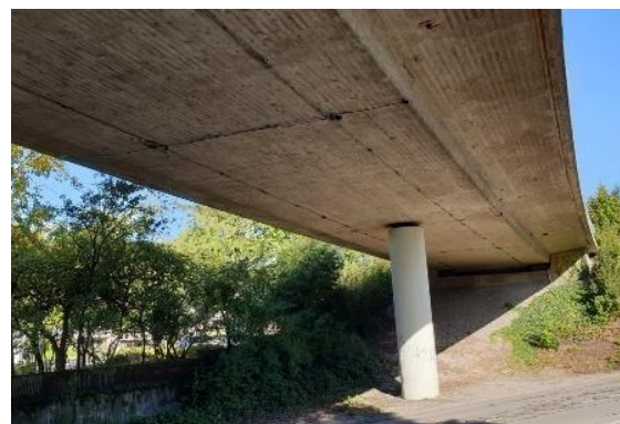
b. Vista do Sistema de monitoramento instalado
