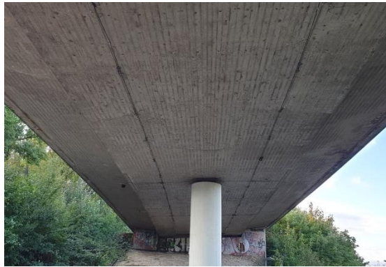
c. Vista do Sistema instalado
