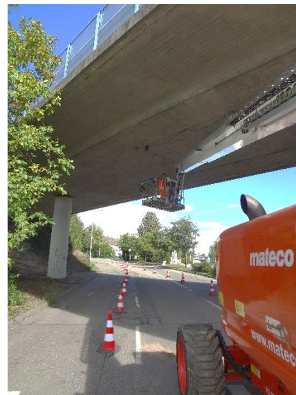
f. Operação da plataforma elevatória
