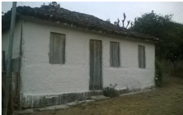
Figura 5 – Detalhe de moradia: utilização de terra crua – foto do autor
