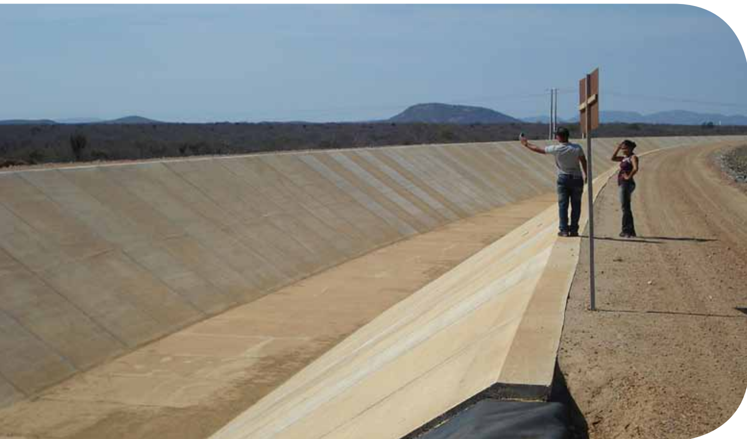
Canal da transposição, trecho que corta área do assentamento Jibóia, município de Cabrobó (PE)
