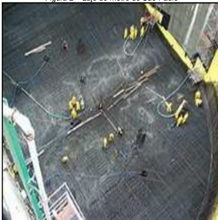
Figura 2 – Laje do metrô de São Paulo
