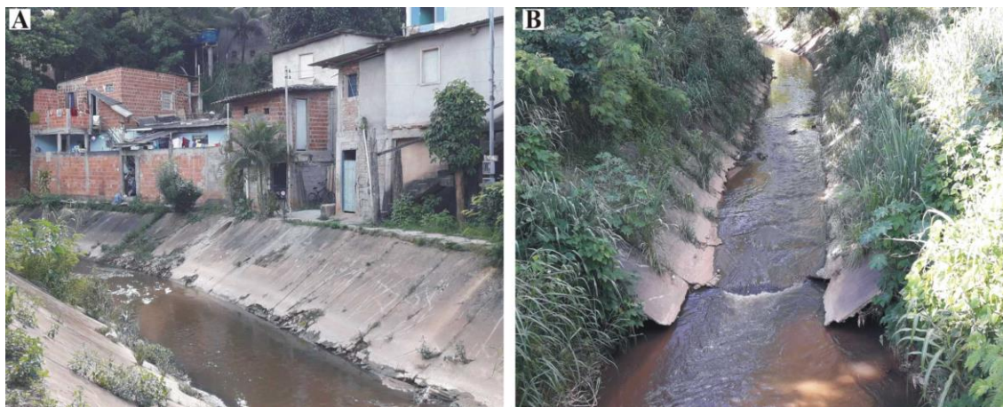
Figura 7 – Aspectos do setor canalizado do Rio Santo Antônio, em Teófilo Otoni (MG). Em A se verifica a proximidade entre as residências e o canal e, em B, o estágio degradado da intervenção de natureza estrutural junto à calha fluvial.
