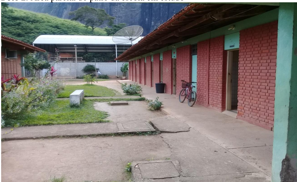
Foto 2. Área parcial do pátio da escola em estudo
