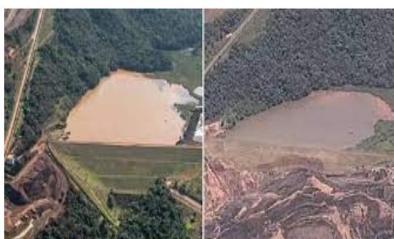
Figura 4 - Rompimento da barragem de Brumadinho antes e depois
