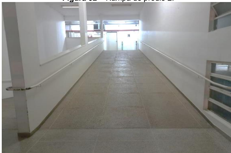
Figura 02 – Rampa do prédio 2.
