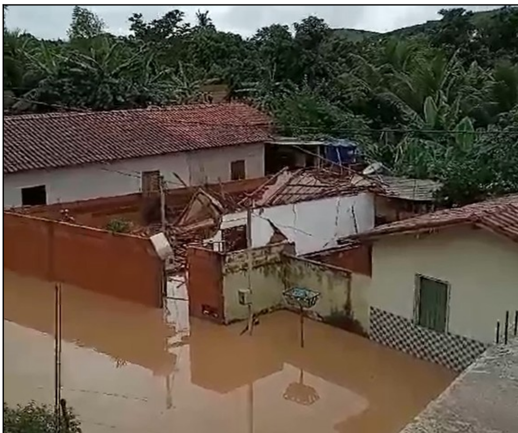
Figura 4: Inundação da Rua Água Branca em Machacalis - MG
